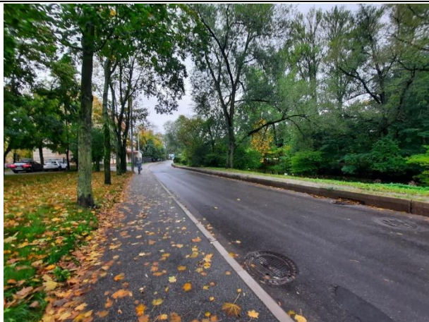
Фото № 1.Подъездные пути
