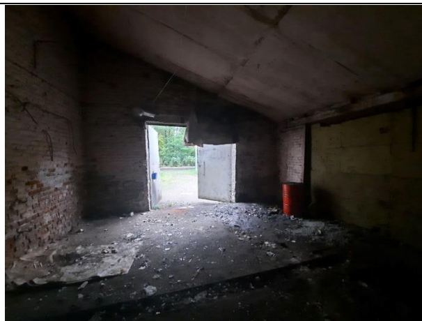
Фото № 14. Внутреннее состояние здания
