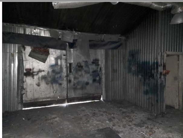
Фото № 16. Внутреннее состояние здания
