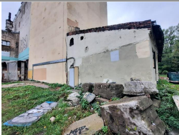
Фото № 11. Внешний вид здания
