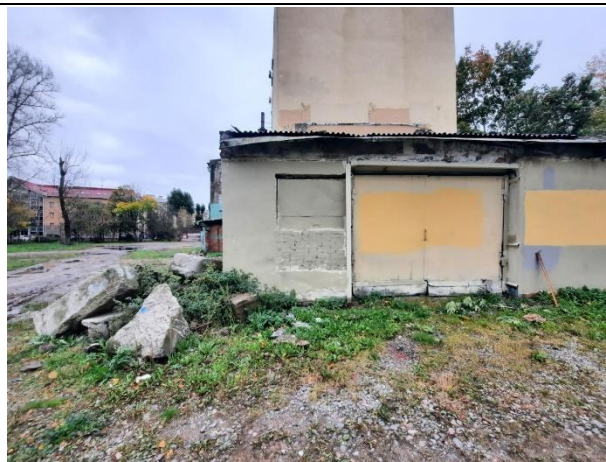
Фото № 10. Внешний вид здания
