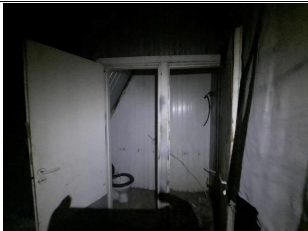
Фото № 19. Внутреннее состояние здания
