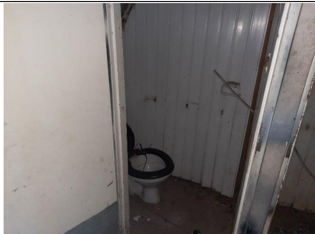
Фото № 20. Внутреннее состояние здания
