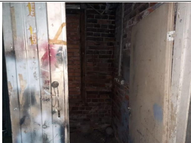
Фото № 18. Внутреннее состояние здания
