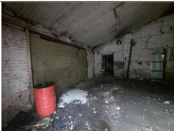
Фото № 13. Внутреннее состояние здания
