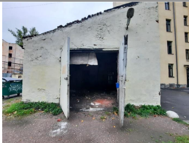
Фото № 12. Вход в здание
