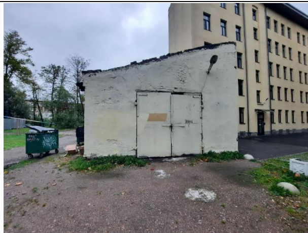
Фото № 8. Внешний вид здания
