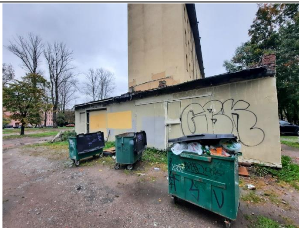
Фото № 9. Внешний вид здания
